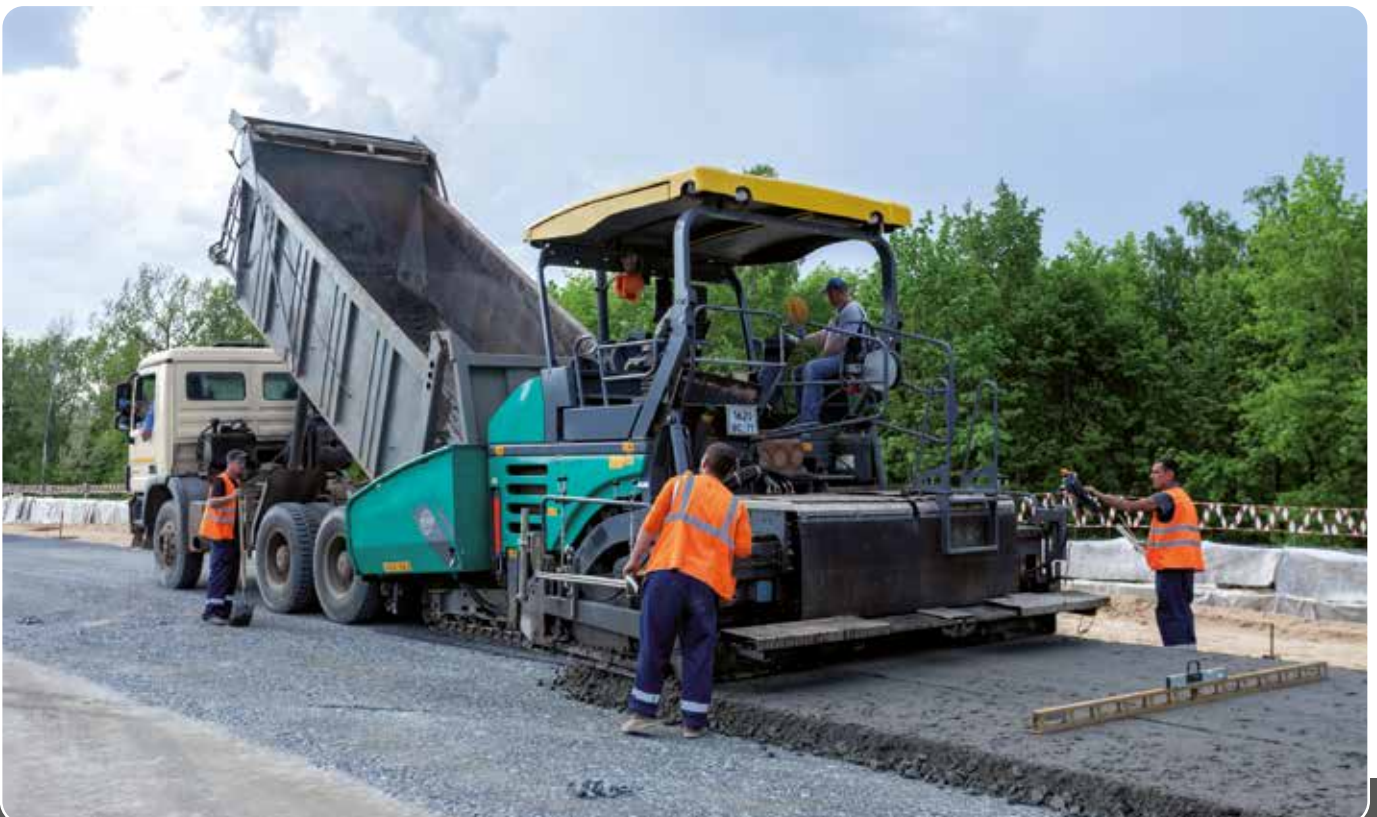
Thermo Container im Asphaltstraßenbau
